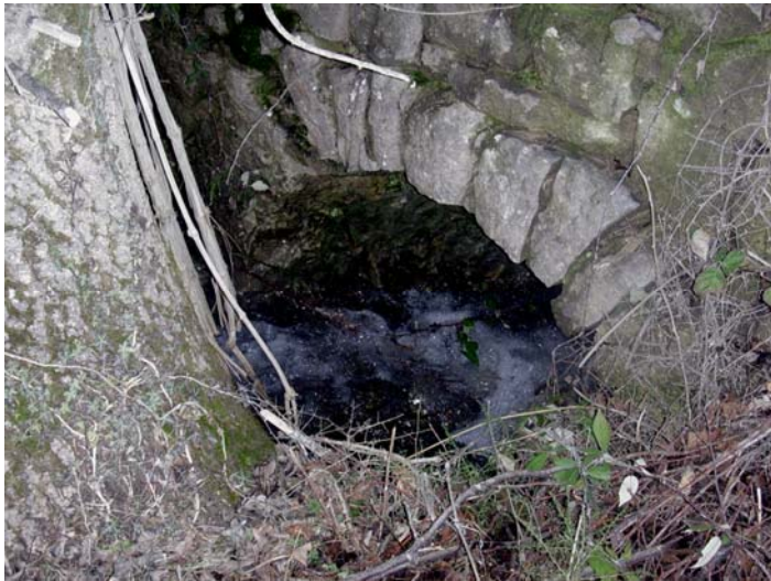
Le ruisseau du Ray poursuit son parcours en franchissant la D563
