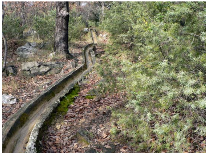
Le canal au profil irrégulier par paliers
