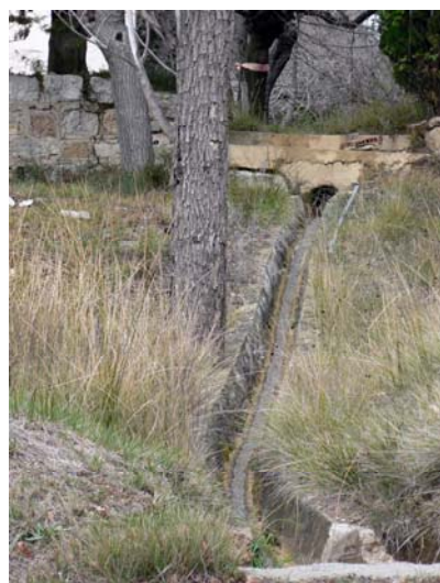
Le canal franchit la D563 par une buse à la Péjade
