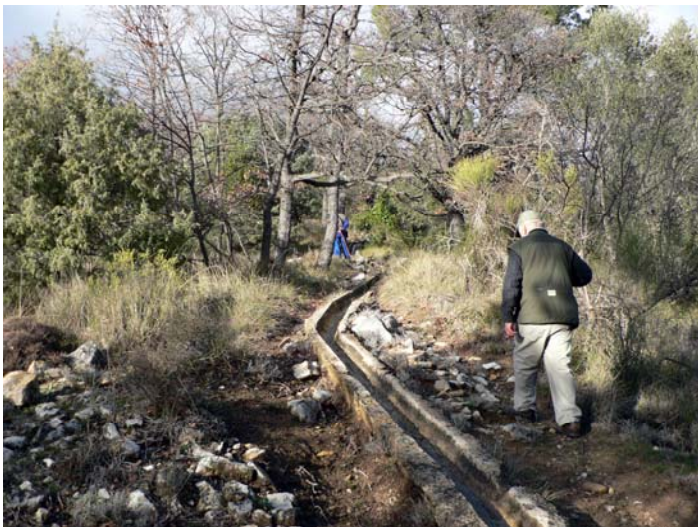
Le canal maçonné serpente dans la forêt
