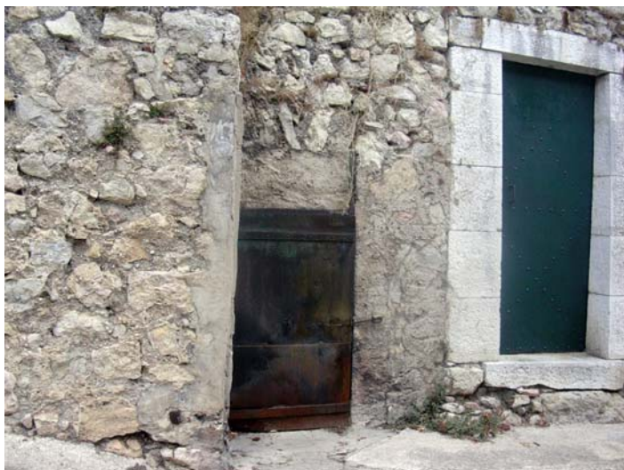
Portillon d'accès au Ray canalisé
