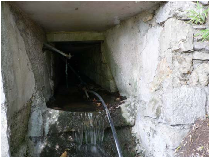
Le Ray canalisé au sud du moulin de la Ferrage
