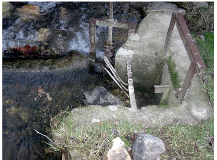
Ouvrage de prise avec à droite la martellière de dérivation des eaux vers le canal
